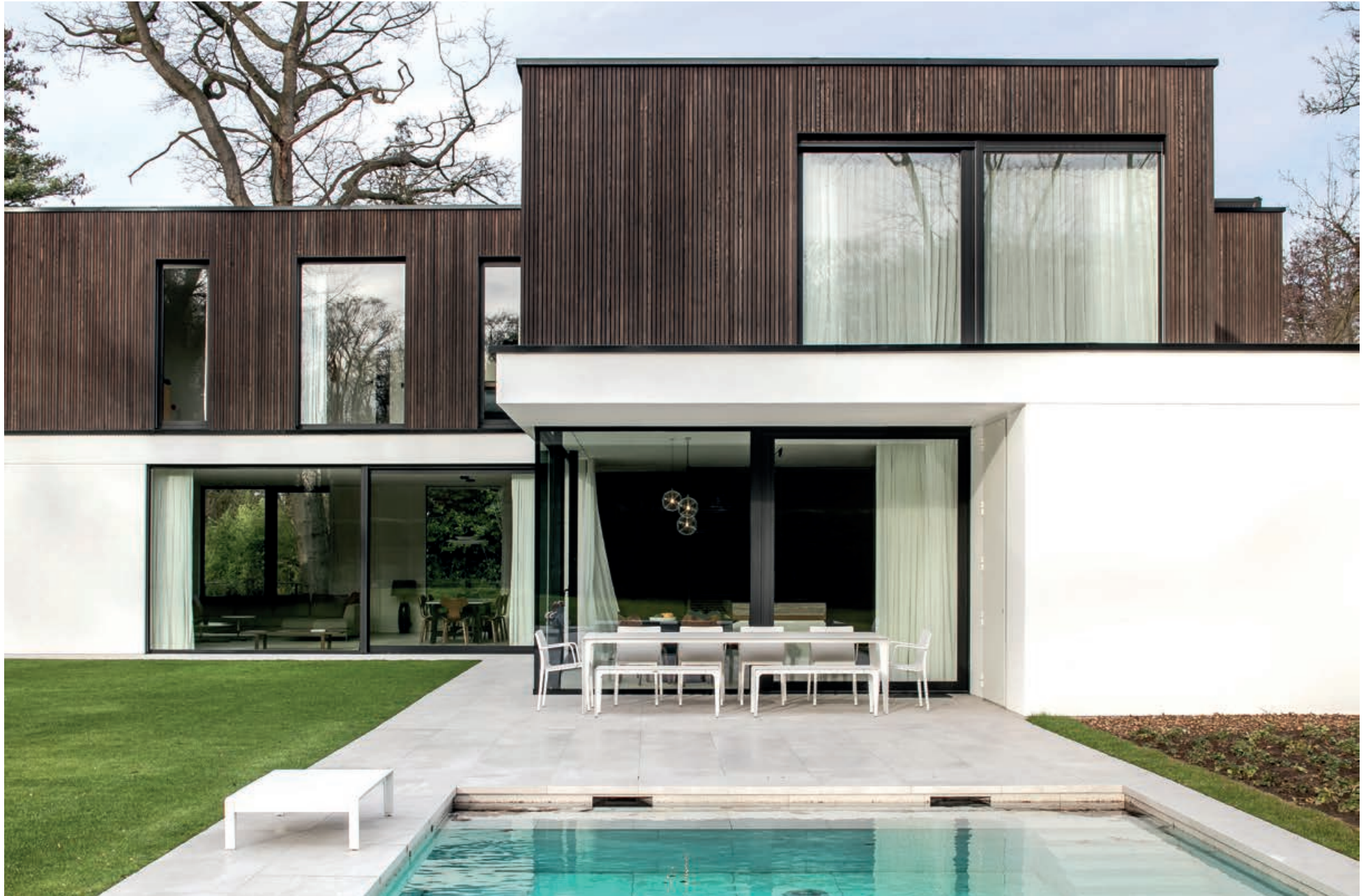
project: SML | hout: HOTwood essen | profiel: SV1 met QuickClip®, behandeld met Rubio Monocoat | architect: Dieter Vander Velpen | uitvoerder: Sels Bouwbedrijf
