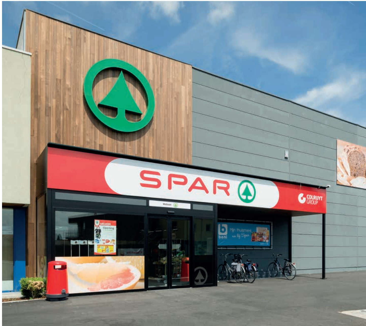
projet : Spar, Emelgem | bois : Frêne thermo-traité | profil : SV+ avec QuickClip®
