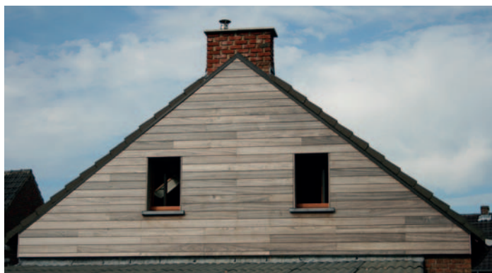
Afb. 3 Gevelbekleding uit planchetten.
