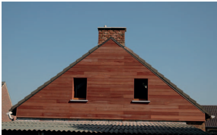
Afb. 35 Plaatsing met tand en groef.
