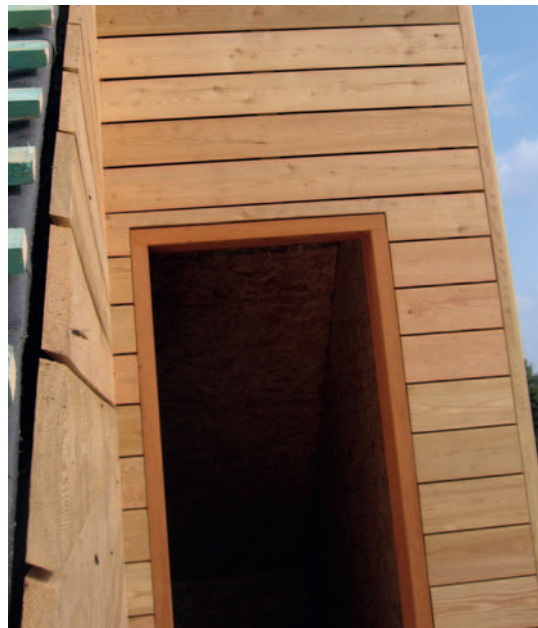
Afb. 36 Ope- ge- werkte plaatsing.
