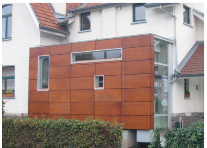
Fig. 9 Revêtement de façade en panneaux.
