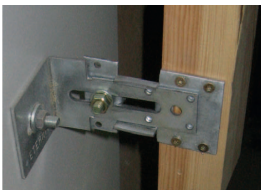
Fig. 29 Attaches métalliques pour la fixation des chevrons.
