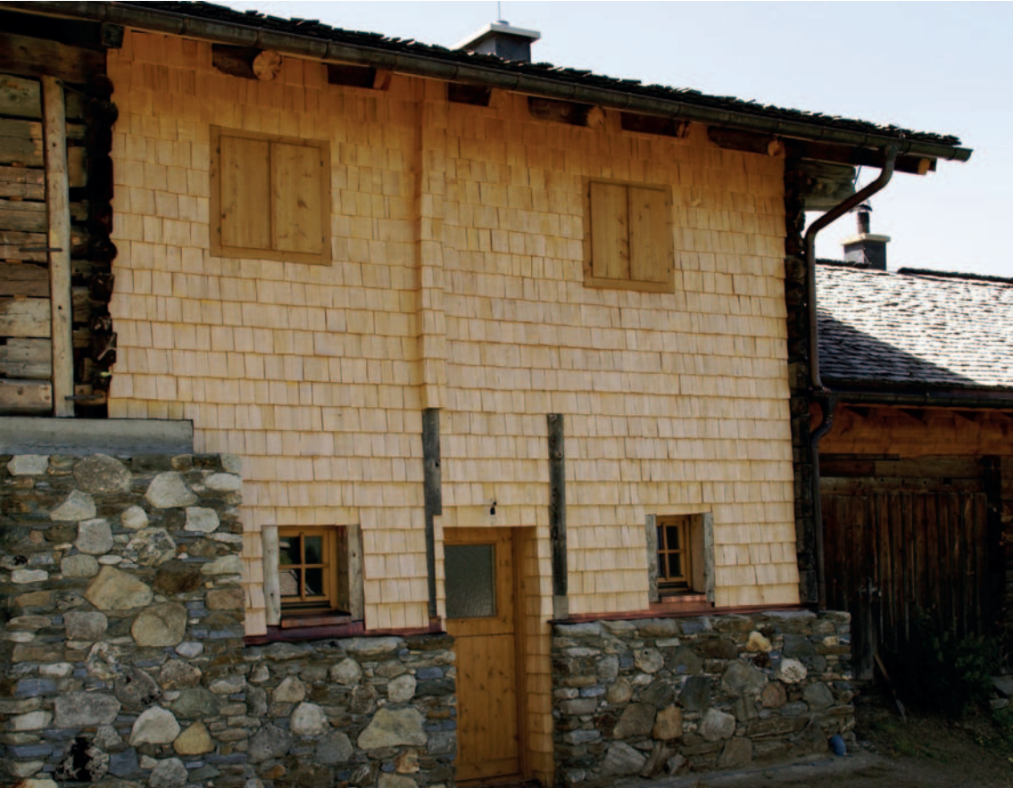
Fig. 10 Revêtement de façade en bardeaux (shingles).
