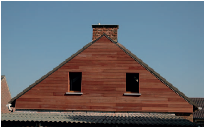
Fig. 35 Bardage posé par rainures et languettes.
